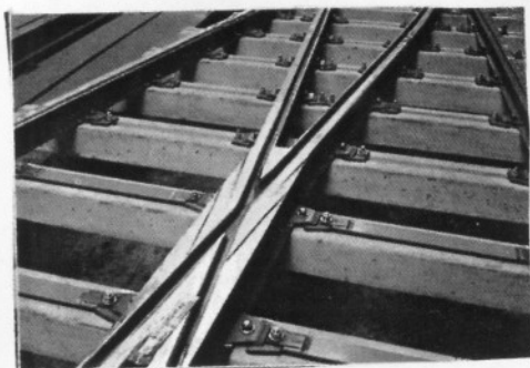
Appareil de voies
